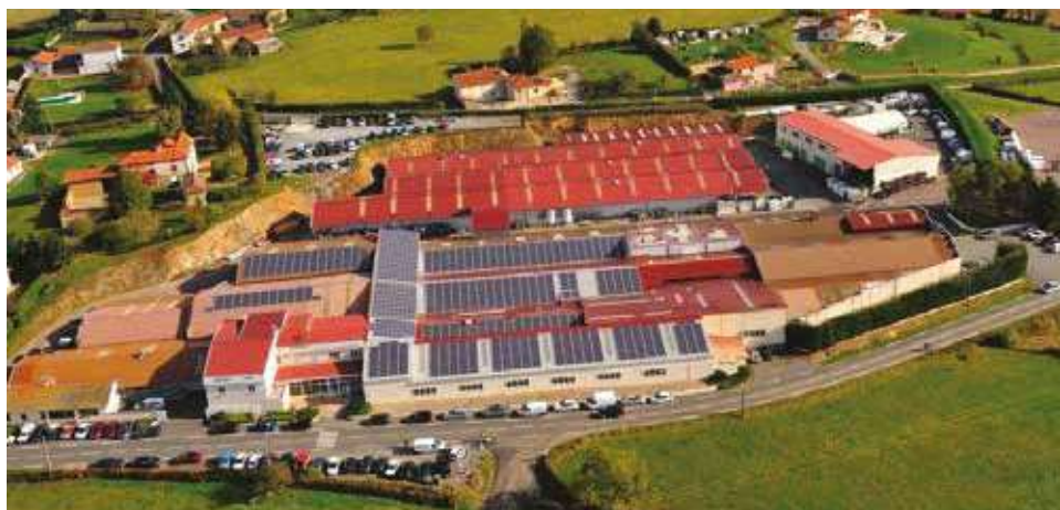
Dans une démarche environnementale, le groupe Doitrand a équipé ses bâtiments de panneaux photovoltaïques.
